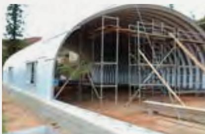
Pendant la reconstruction (coll. Patrimoine de Tiébaghi).
