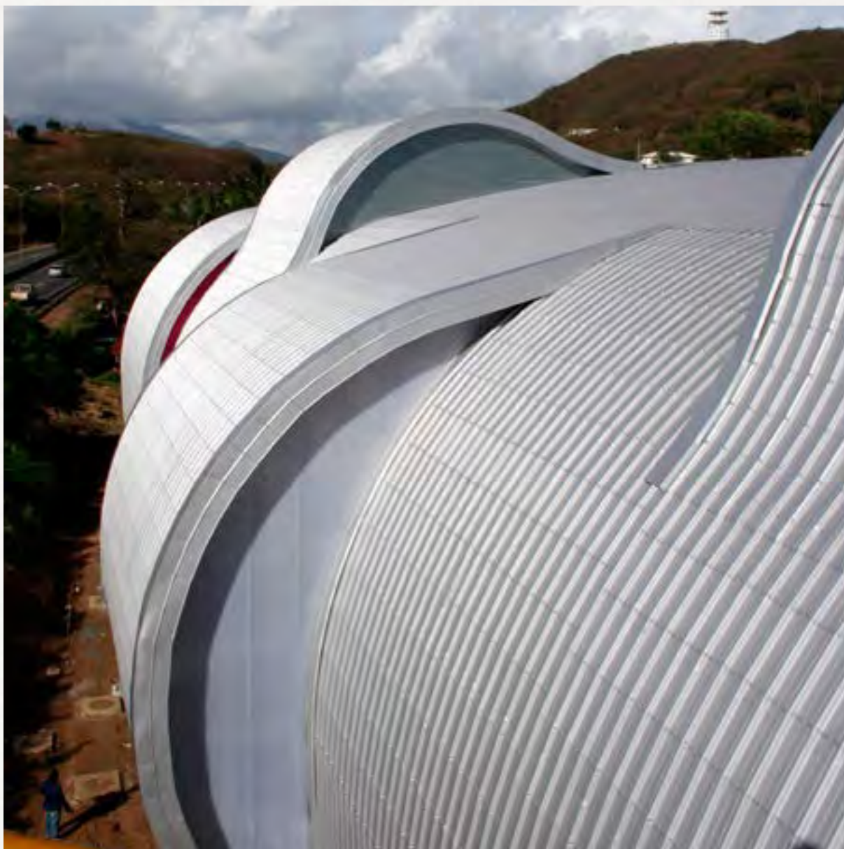
Tôles extérieures du gymnase François Anewy (coll. Ville de Nouméa).
