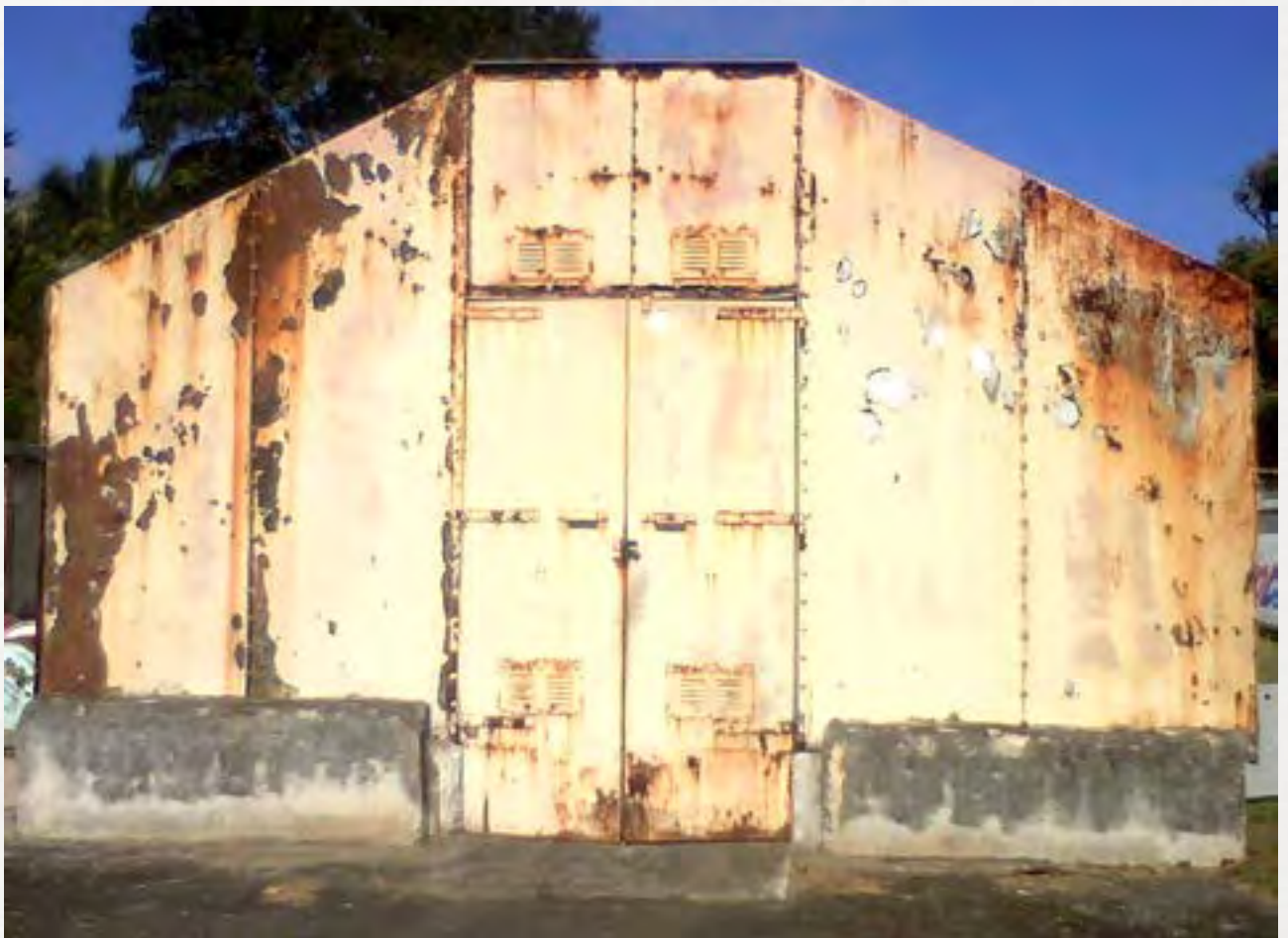
La devanture en métal renforcée est typique des docks de munitions ou carburant enterrés (coll. FP 2013).
