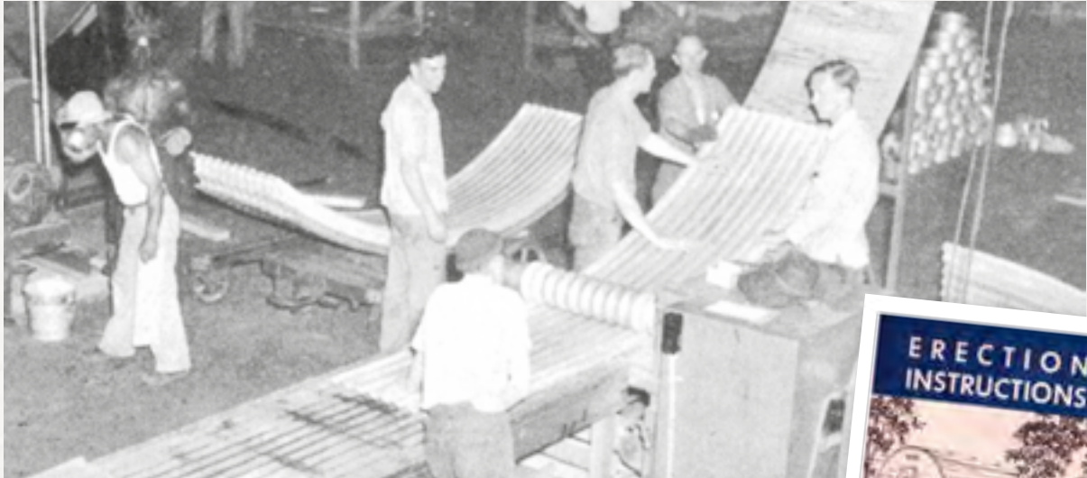
Atelier de fabrication des tôles à l'usine de Davisville, 1941 (coll. FP).
