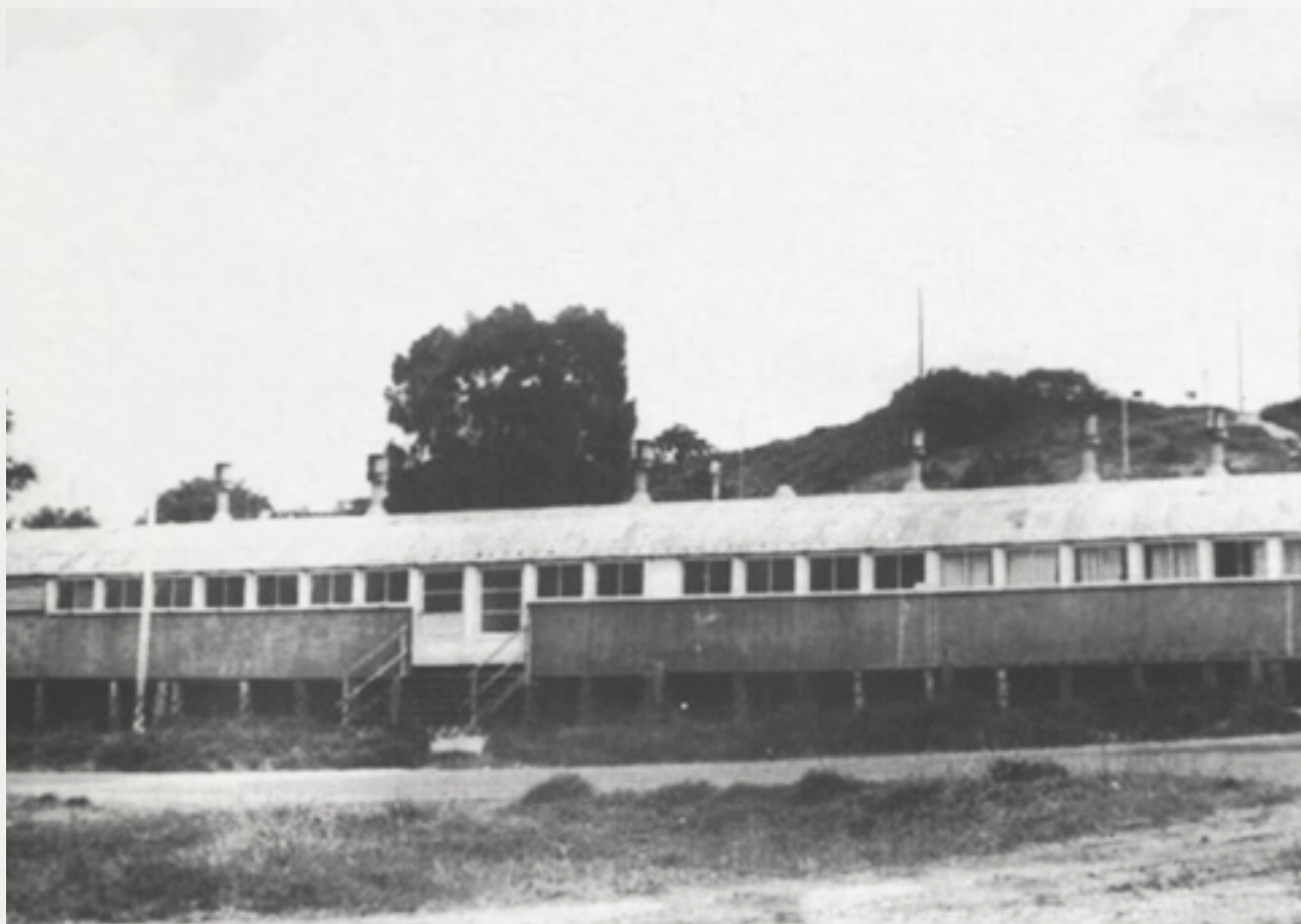
La demi-lune réfectoire devenue école au Receiving après la guerre (coll. Viale).
