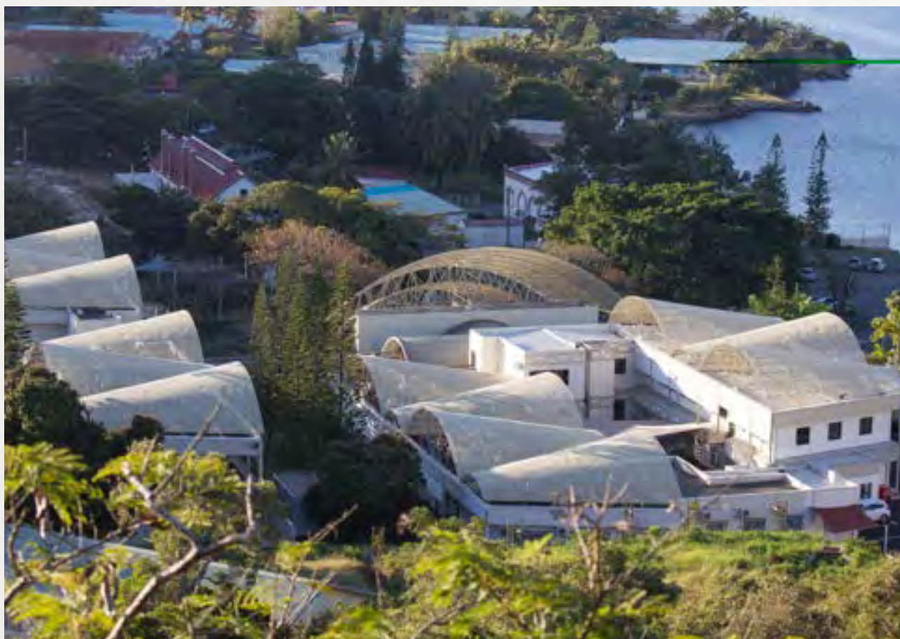
Toits des bâtiments administratifs et du département des sciences de l'UNC (coll. FP 2013).
