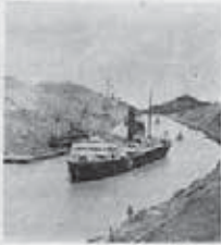
AUX ÉTRIÈLEMENTS DE COCKSWAIN Un vapeur passe devant l'étrémeur qui se situe dans le canal aux étrières de 1919.
